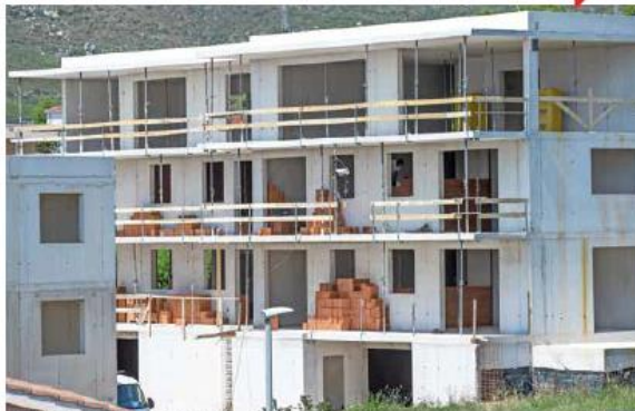
Bučno gradilište u Mosorskoj ulici
